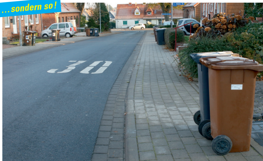
Vorbildlich: Die Abfallbehälter blockieren weder Straße noch Gehweg, das Sammelfahrzeug kann die Behälter direkt anfahren und problemlos entleeren.
